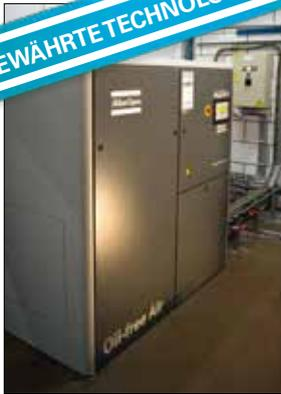
Im AQ befindet sich ein einzigartiges Schraubenelement mit Wassereinspritzung für eine hocheffiziente, nahezu isothermische Kompression.
